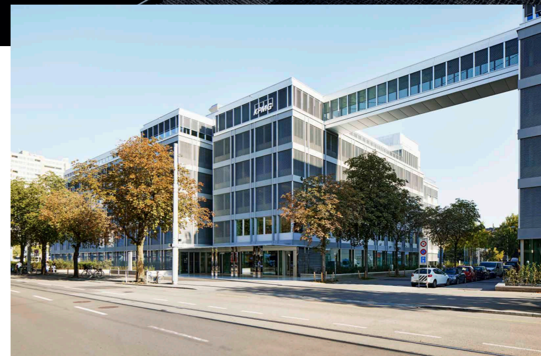
Der KPMG-Hauptsitz in Zürich, eingerichtet mit hochwertigen USM-Haller-Möbeln
